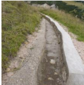
Fotografía. 4-18. Uso de roca en canales
