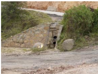
Fotografía. 4-16. Uso de roca en obras civiles
