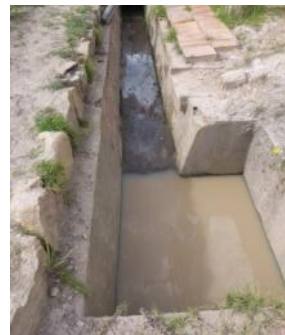
Fotografía. 4-17. Uso de roca en canales
