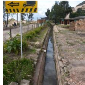
Fotografía. 4-19. Uso de roca en canales
