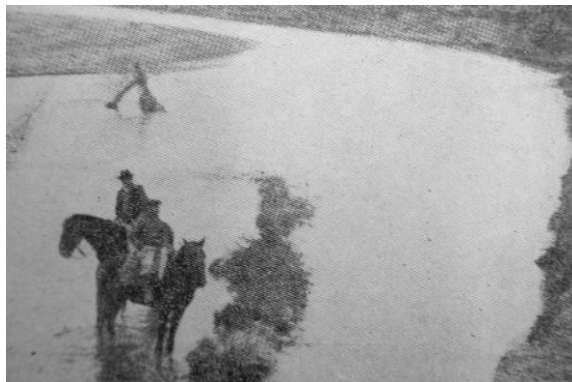
Figura III. Toma ilegal de agua en el río Tunuyán en su tramo superior
