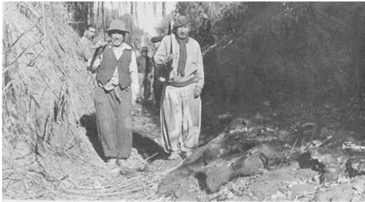
Figura I. Trabajadores a pala en el canal Montecaseros. Departamento de San Martín, 1955
