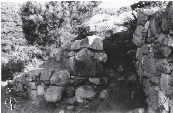
Figura 5. Imatge presa a la intervenció de 1988 (Miró 1988) dels murs en corba que es lliuraven al llenç sud-oest de la torre sud.
