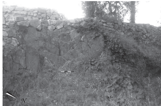
Figura 15. Escarpat excavat a la roca natural que conforma la 2ª terrassa.
