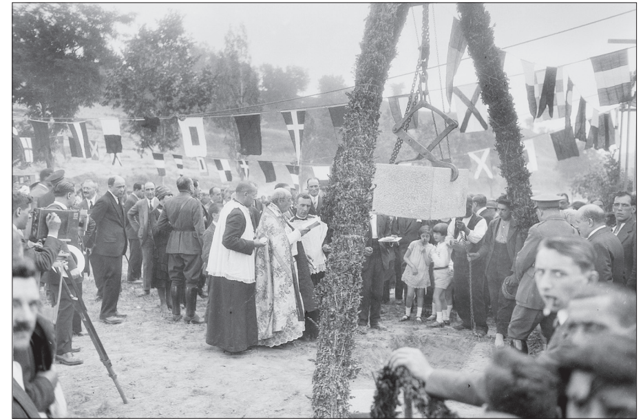
Un jove amb una càmera amb trípode pren imatges de la primera pedra, suspesa d'uns ernalts, abans de ser col·locada al forat exprés que hi ha dessota. Arxiu Nacional de Catalunya (ANC). Fons Brangulí.
