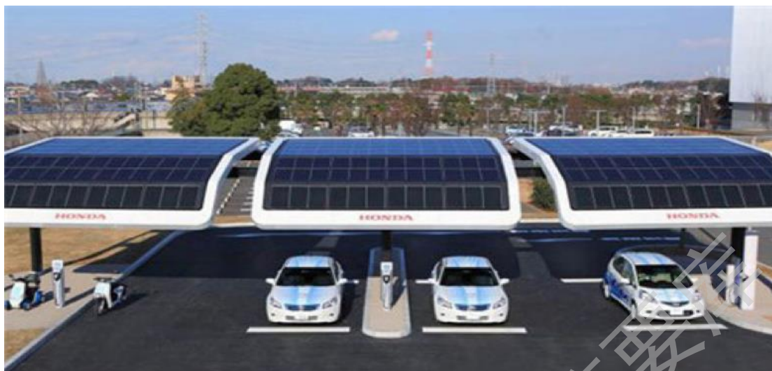
图 1.1 太阳能光伏汽车充电站
