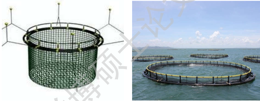
图1-2 HDPE圆柱形浮式深水网箱
