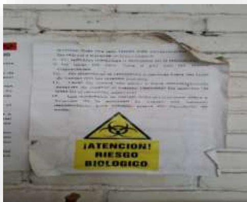
Señal semi despegada, deteriorada y no visible
