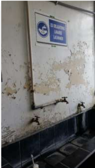
Pintura de paredes deterioradas
