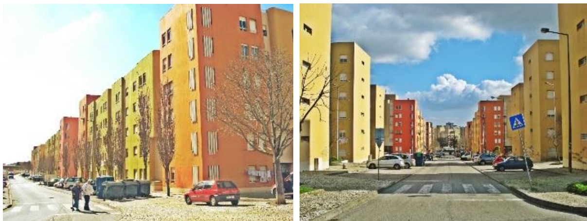
Fig. 77a, 77b - Edifício do Bairro Novo Fonte: Autor
