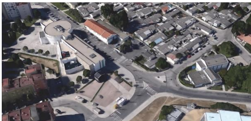
Fig. 79 - Vista aérea sobre Biblioteca, Centro Cultural, Mercado a Igreja Fonte: Google Earth
