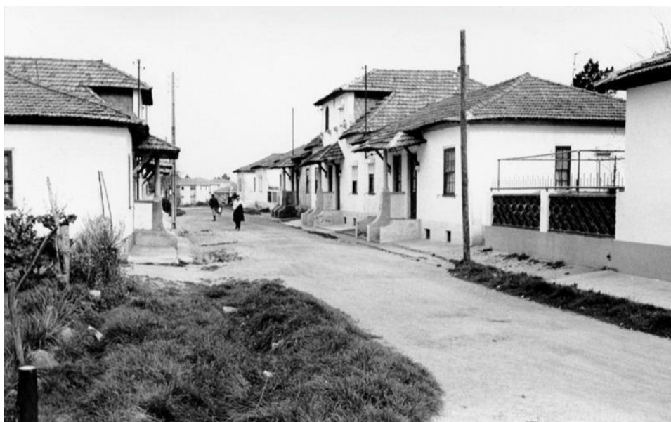
Fig. 15 - Bairro operário da Areosa
