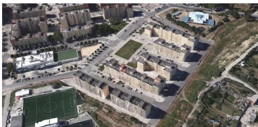
Fig. 78 - Vista aérea correspondente à expansão da 4.ª fase Fonte: Google Earth
