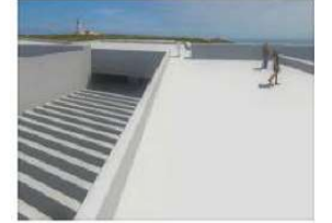
3 Vista do Miradouro
