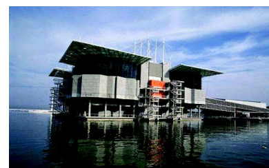
FIG. 25. Oceanário de Lisboa no Parque das Nações, fotografia da autora, 2015.
