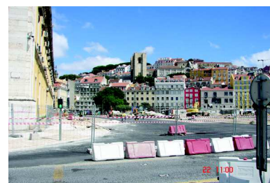
FIG. 74. Campo das Cebolas em obras, fotografia da autora, 2016.
