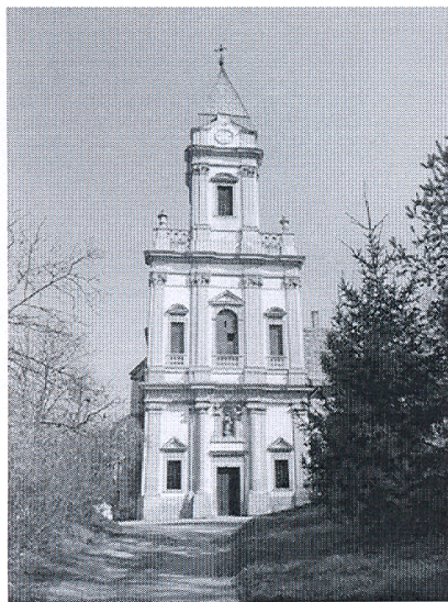
12. ábra. a) Széchenyi Pál első temetkezési helye a sopronbánfalvi templom altemploma volt. Innét vitette át gróf Széchenyi Ferenc a múmiát 1811-ben a családi mauzóleumba, Nagycenkre.
