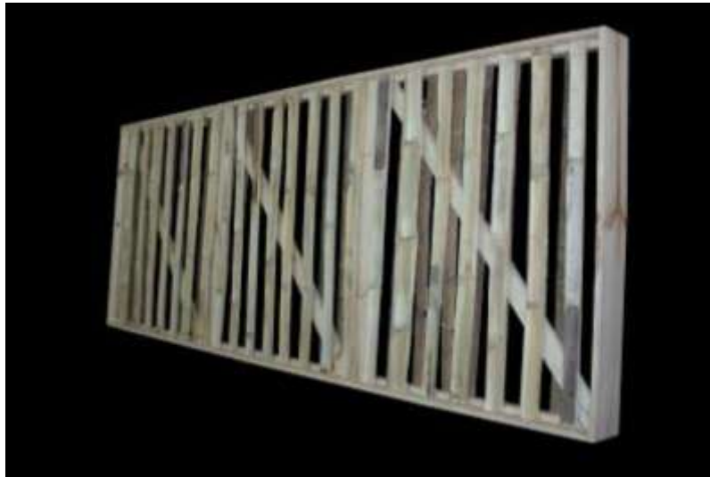
Figura 179. Estructura en madera. Panel de bahareque
