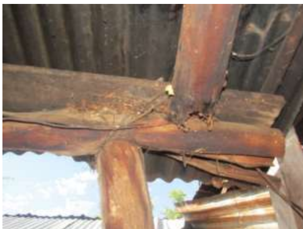
Figura 170. Ausencia de inmunización
