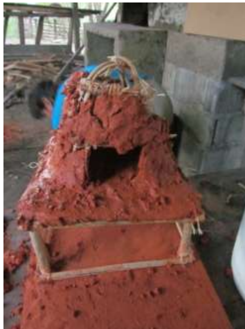
Figura 7. Aplicación de mezcla sobre el enjaulado
