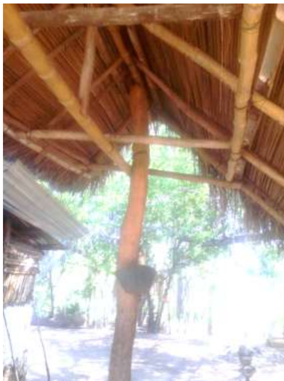
Figura 171. Imperfecciones de la madera o guadua.
