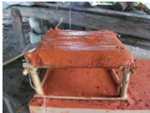
Figura 5. Relleno de mezcla para el soporte
