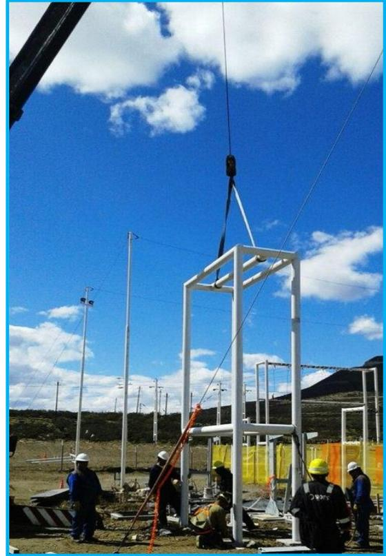
Este se realiza con el uso de Grúa, la cual se posiciona lo más próxima a las bases del pórtico con un peso de 1.900 kg , desde el eje centro de la grúa a el pórtico existe un radio inicial de 6mts.
