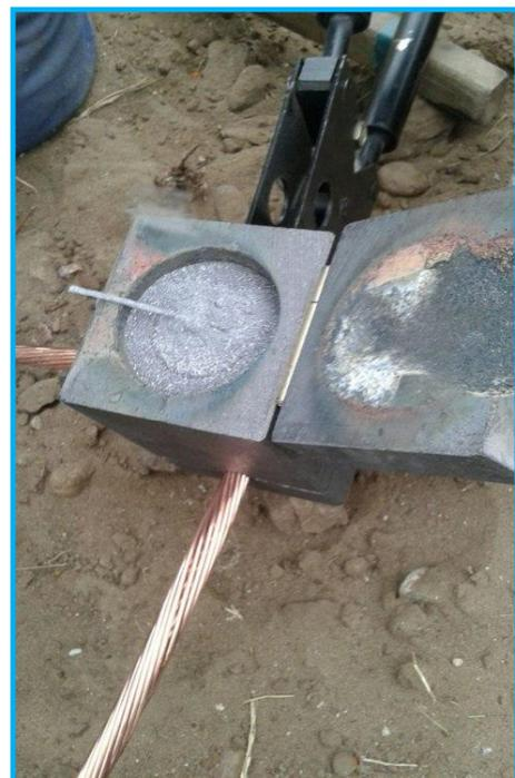
Para las derivaciones de la malla se utilizan cables cuya formación de hilos sea similar a la del cable de la malla. No se manipulan cables extra flexibles o del tipo VN, ya que los hilos que conforman estos cables son demasiado finos para soportar las elevadas temperaturas de la soldadura.
