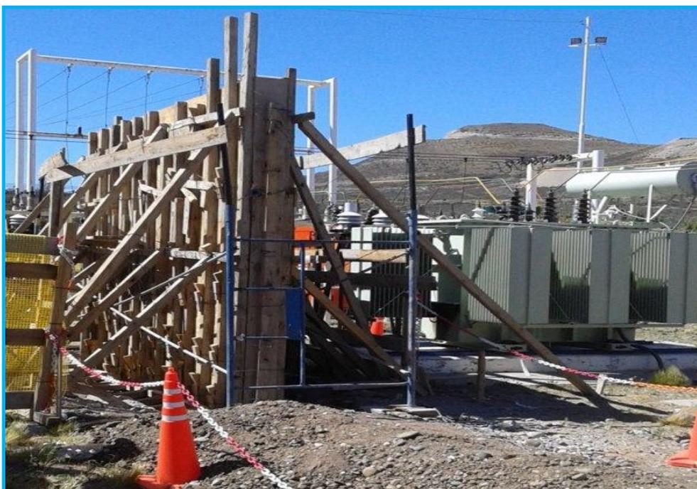
El armado del encofrado para la pared del muro se efectuara con enchapado de fenolicos, siendo de 18mm espesor X 3400mm de alto X 4000mm de ancho.
