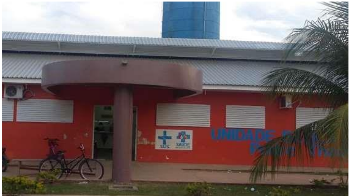
Figura 1: UBS/ESF Padre Teodoro. Fonte: Arquivo Próprio
