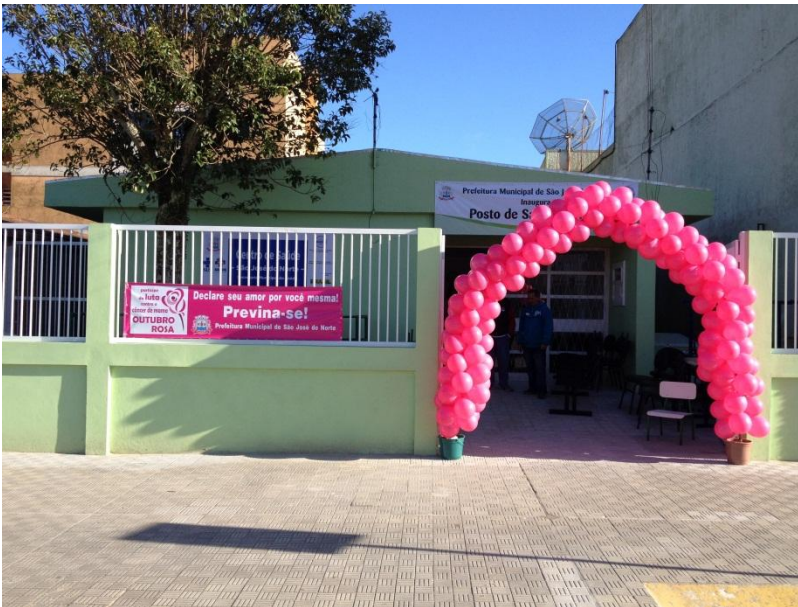
Figura 2. Entrada unidade nova e reformada do Centro de Saúde de São José do Norte/RS, inaugurada em outubro de 2014.
