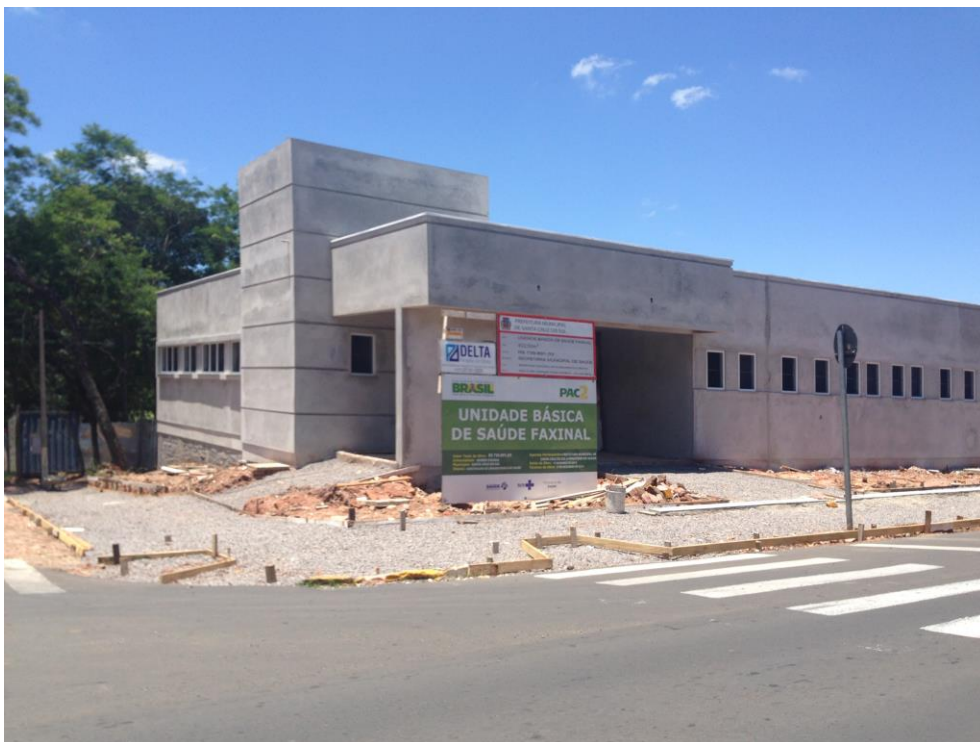
Figura 23: Fachada da nova Unidade em construção Fonte: Acervo pessoal, 2014
