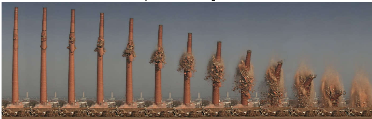
Obr. č. 7: Odstřel továrního komínu pivovaru Henninger ve Frankfurtu nad Mohanem
