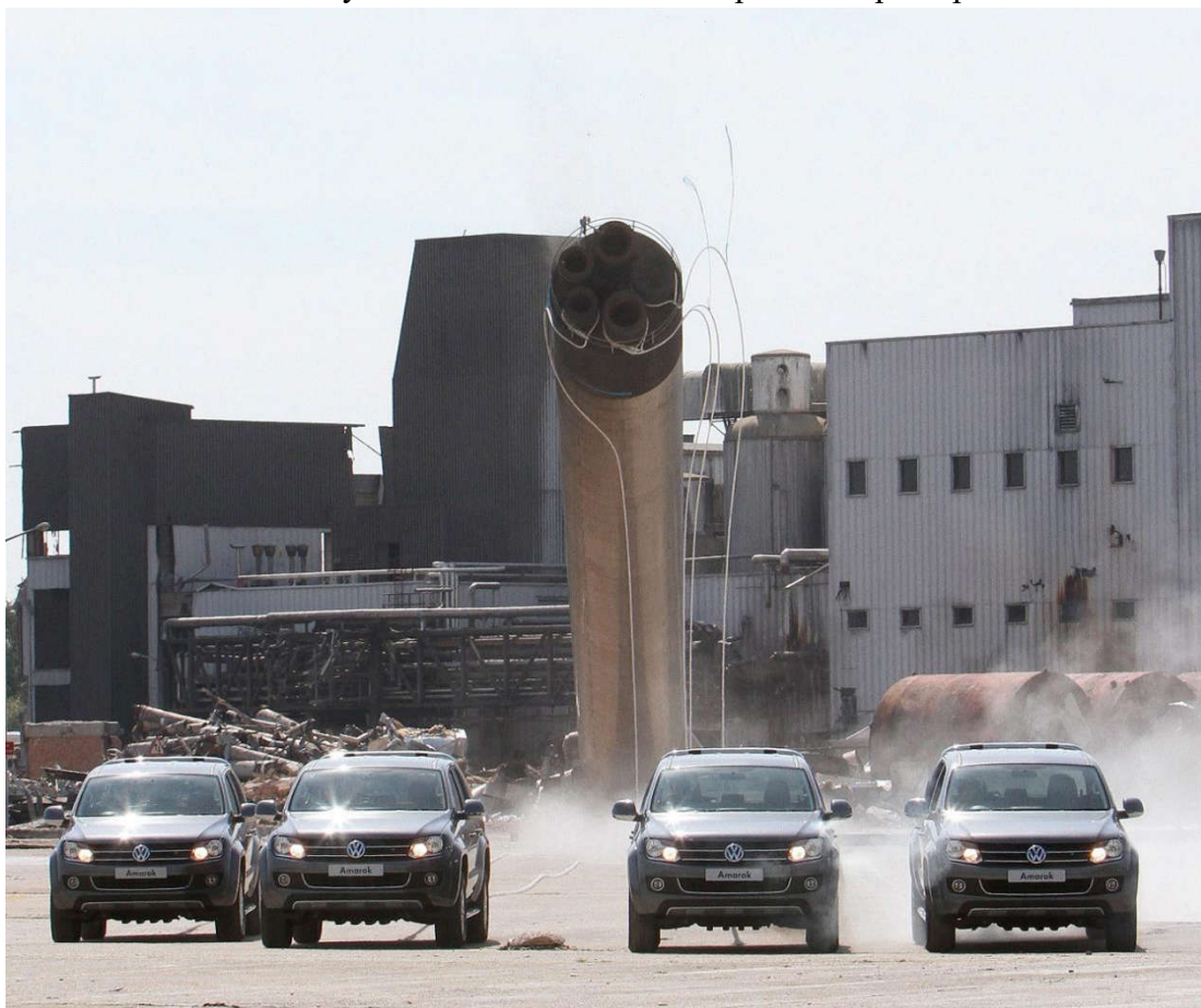
Obr. č. 2: Stržení 67m vysokého ocelového komínu pomocí 4 pick-upů.
