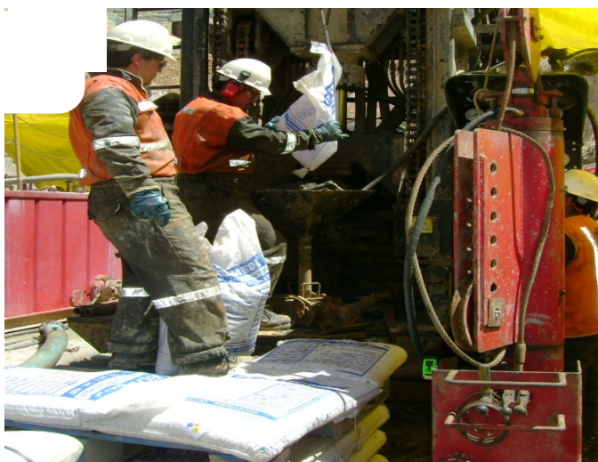
FIGURA 19. Colocación de Grava en la zona anular del pozo. Fuente Drillex International Perú SAC
