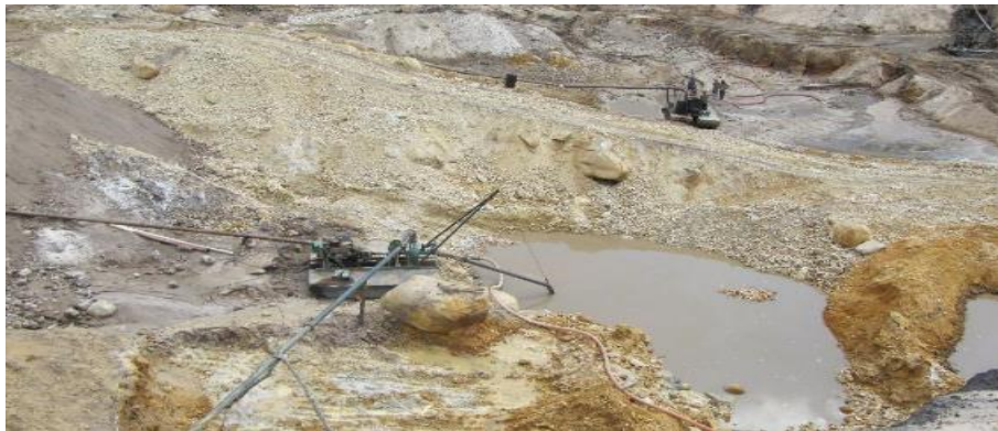
Fig. 4: Utilização de bombas dentro das cavas para o desmonte hidráulico do talude. Fonte: Baggio, 2016.
