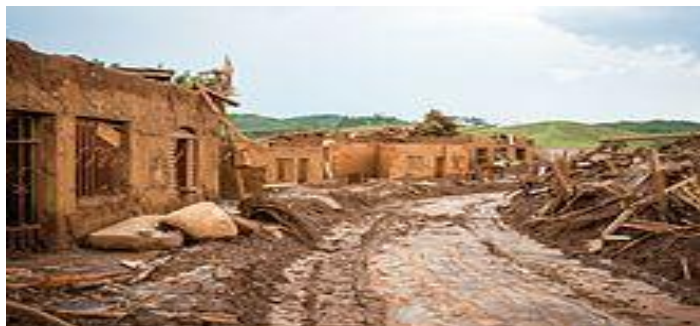
Rua de Bento Rodrigues, Mariana, após o desastre.
