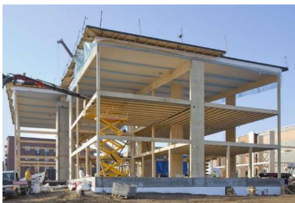
Kuva 20. Havainnekuva pilari-palkkirakenteesta Viikin Latokartanon työmaalta 2011 (Puuinfo)
