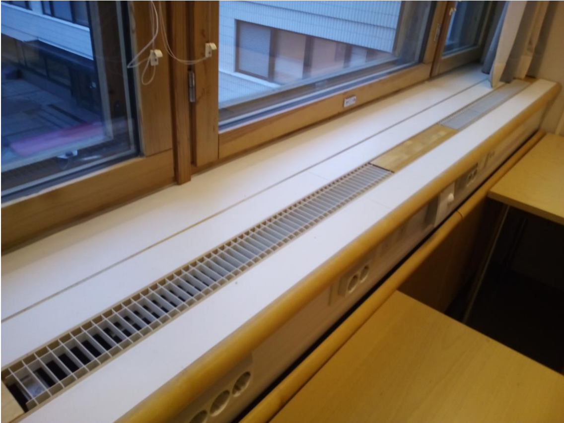
KUVA 4. Ikkunaseinustan kotelointi esimerkkikohteessa
