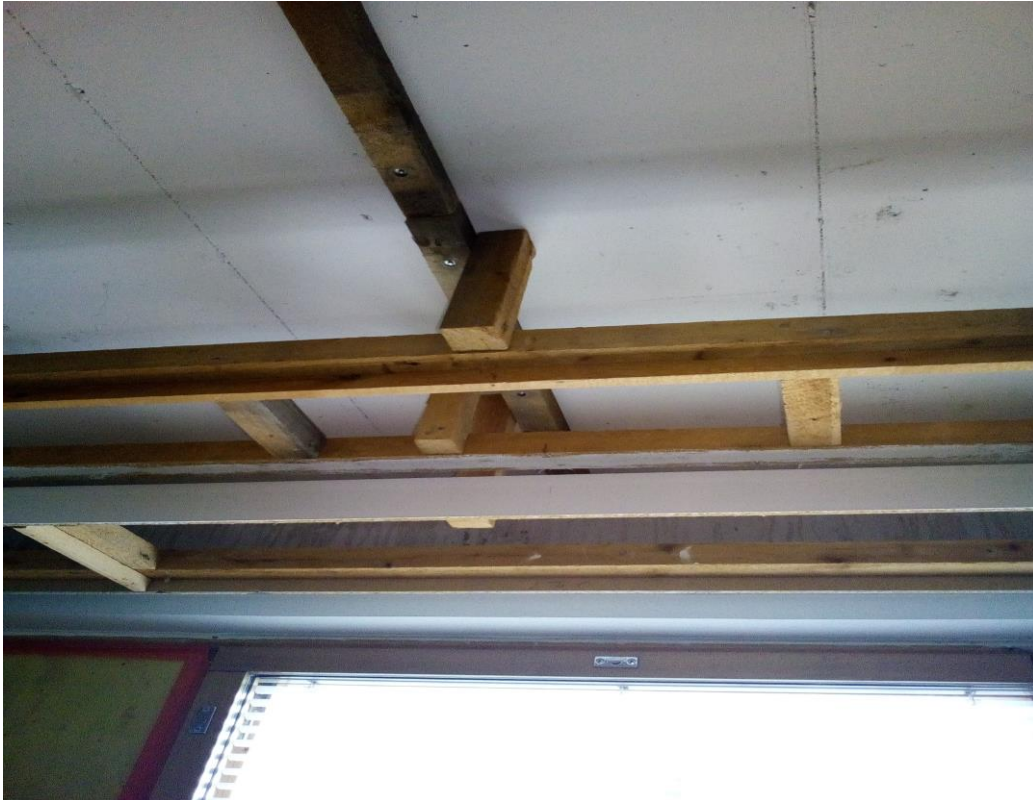
KUVA 8. Purettava alakattorunko
