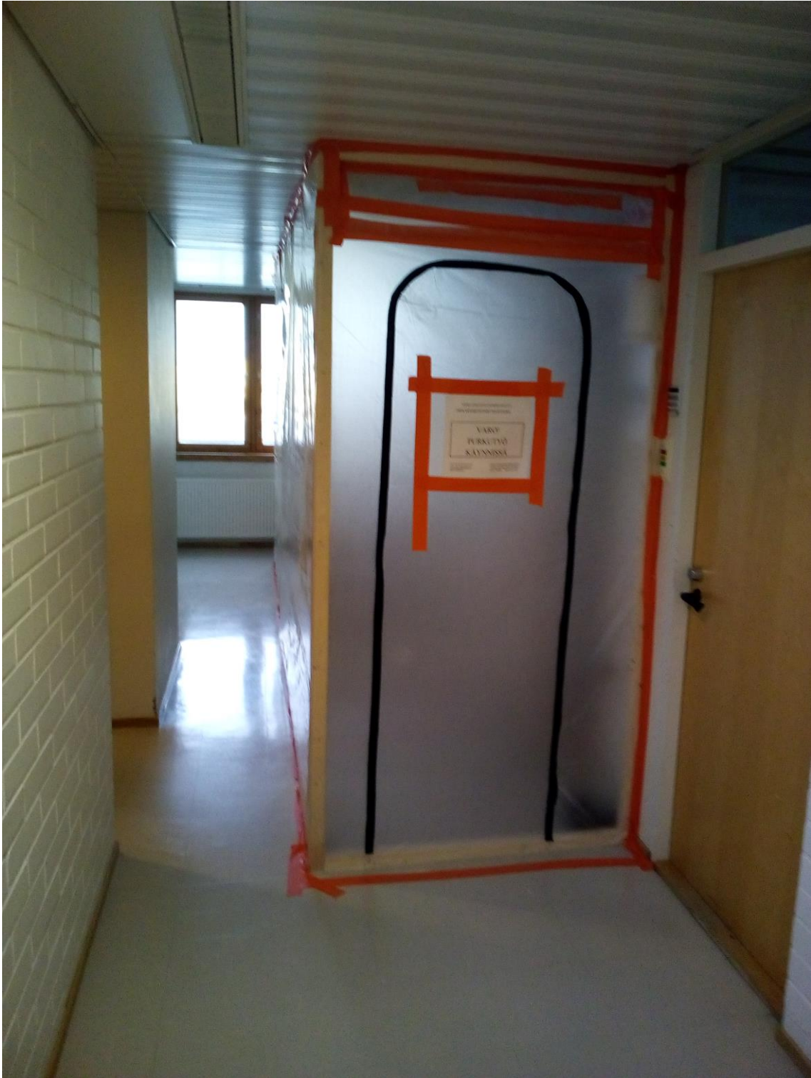
KUVA 5. Käytävän osaston suojaseinä esimerkkikohteessa
