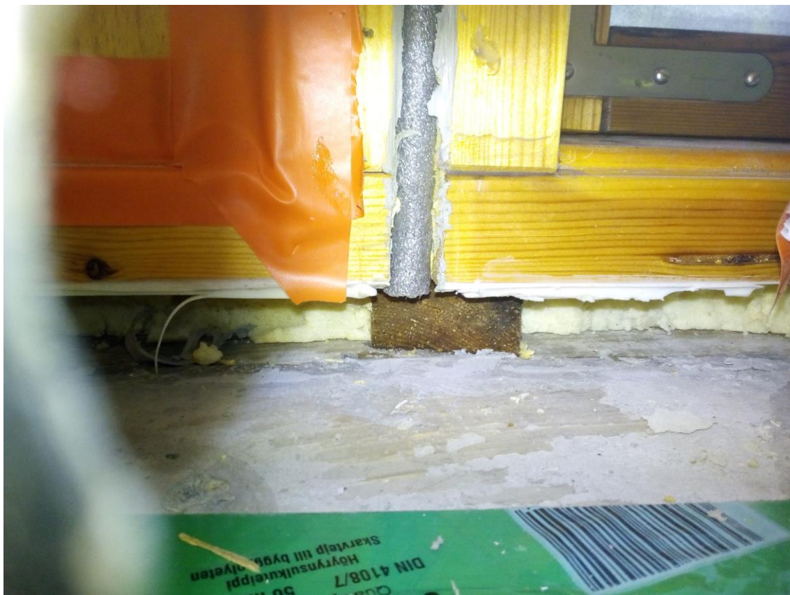
KUVA 6. Ikkunan puukiilat esimerkkikohteessa
