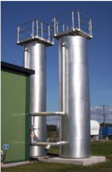
Kuva 6. Rautaoksidia sisältäviä säiliöitä jotka poistavat rikkivedyn biokaasusta. (Ruotsi)
