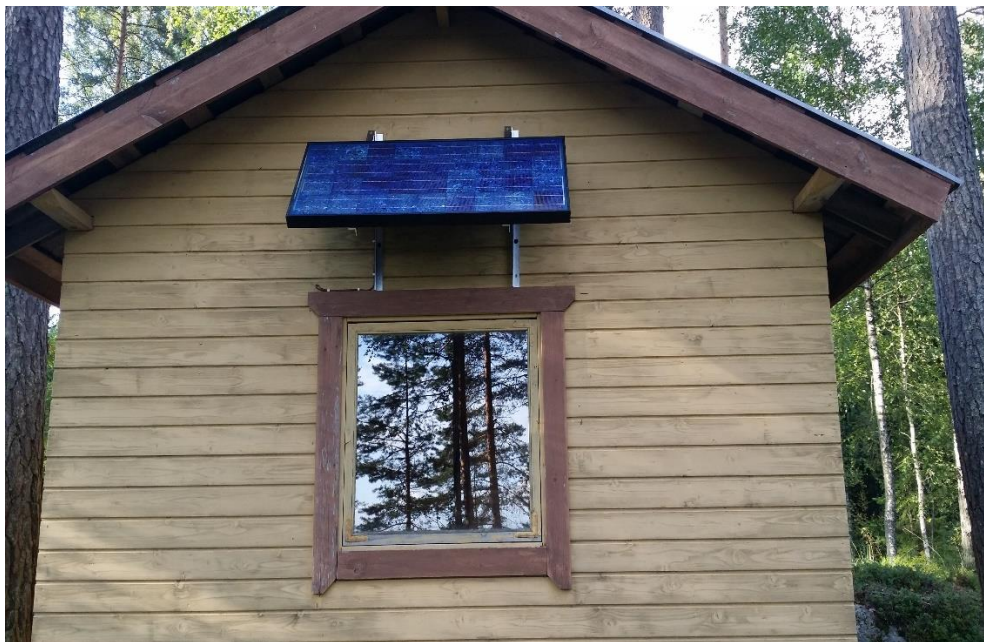
KUVA 16. Yhden aurinkopaneelin kiinnitys seinärakenteeseen (valokuva 2016)
