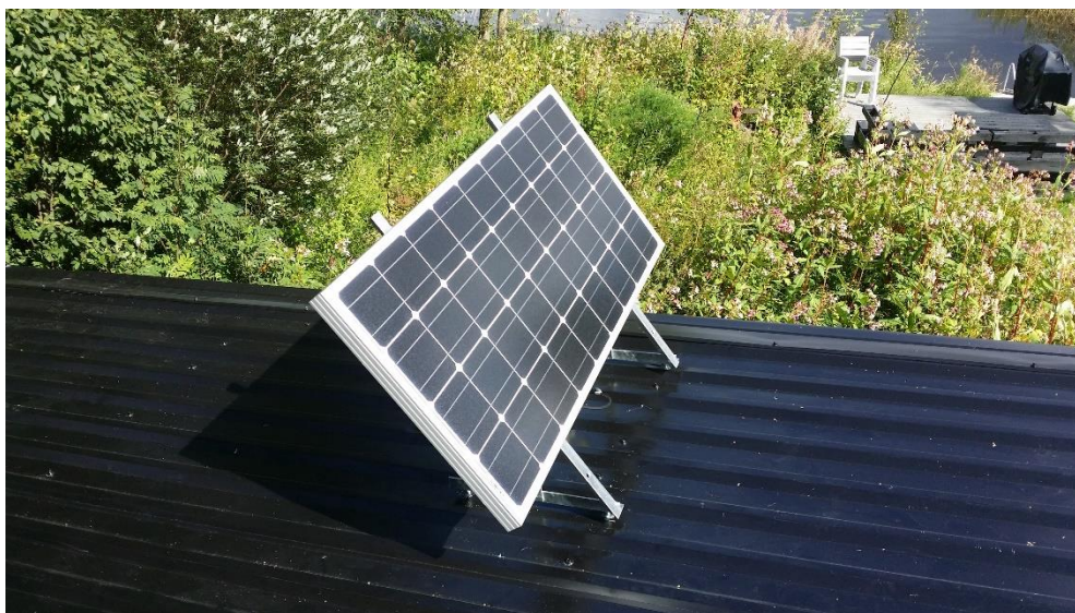
KUVA 15. Yhden aurinkopaneelin kiinnitys kattorakenteisiin (valokuva 2016)
