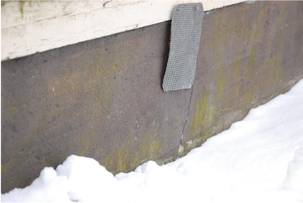
Kuva 3. Ryömintätilan tuuletusaukko ja perusmuurin pintaa.
