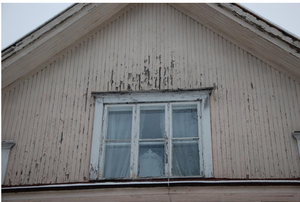
Kuva 5. Eteläpäädyn yläkerran julkisivu.
