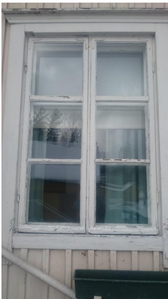
Kuva 8. Ikkunan kuntoa ulkopuolelta.
