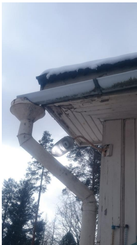
Kuva 2. Räystään ja syöksytorvien kunto.
