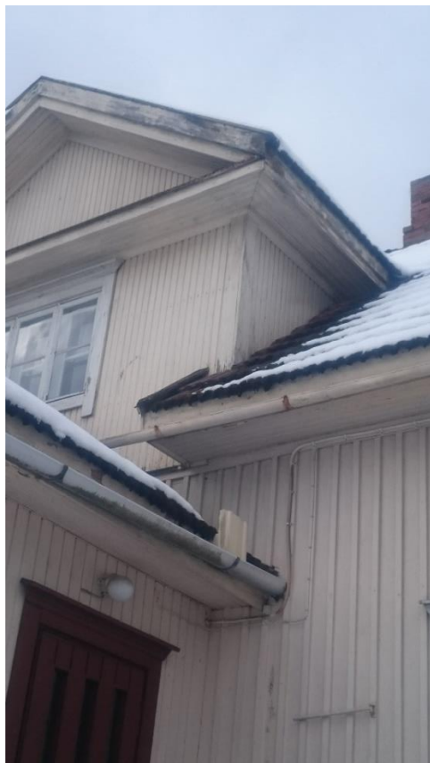
Kuva 6. Länsijulkisivun räystääslaudoitus.
