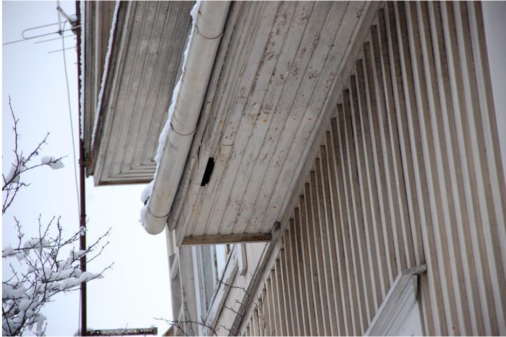
Kuva 6. Länsijulkisivun räystääslaudoitus.
