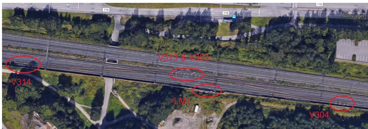
Kuva 11. Leppävaaran aseman itäpuolella sijaitsevat lämmitysmuuntaja LM1 ja vaihteet 303, 304, 313 ja 314.
