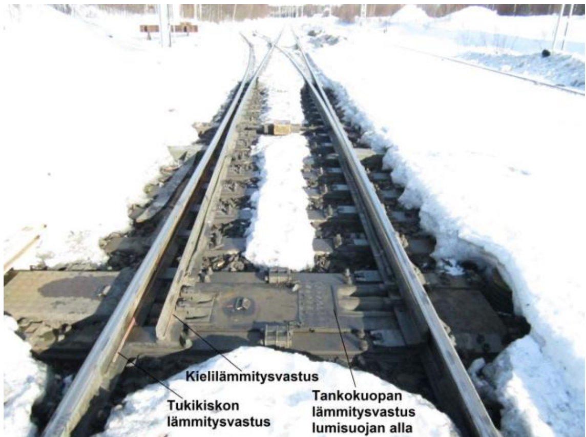
Kuva 1. Vaihteenlämmitysvastuksien sijoituspaikat vaihteessa [5]
