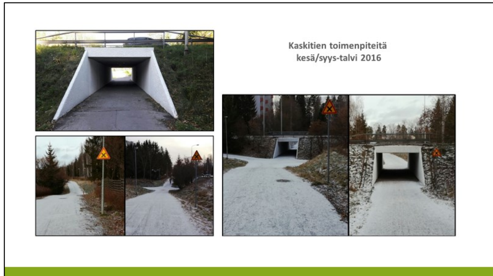
Kuva 40. Kaskitien alikulkutunneli toimenpiteiden jälkeen.
