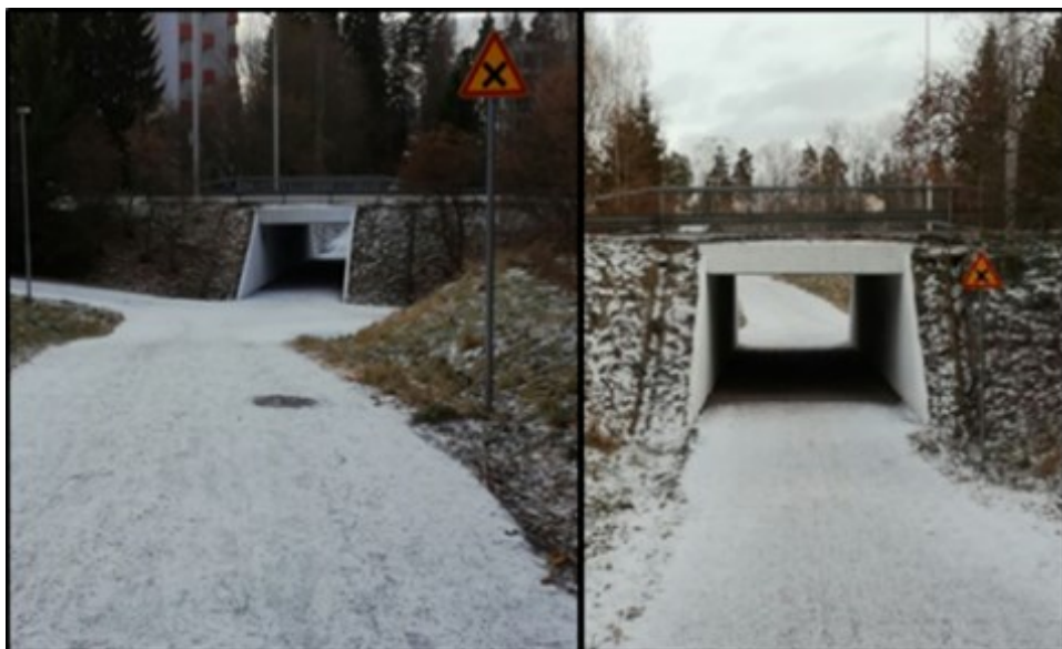
Kuva 24. Kaskitien alikulku liikenneturvallisuustoimenpiteiden jälkeen. Alikulku maalattiin valkoiseksi syksyllä 2016 ja alikulun läheisyyteen lisättiin risteyksestä varoittavia liikennemerkkejä.
