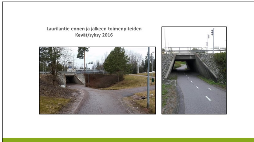
Kuva 41. Laurilantien alikulkutunneli toimenpiteiden jälkeen.
