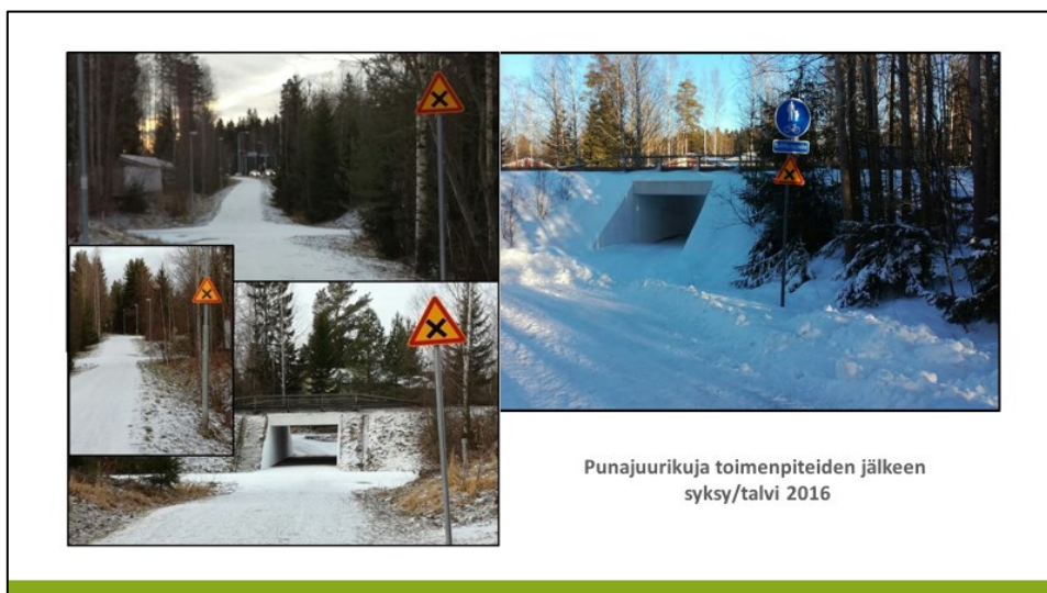
Kuva 38. Punajuurikujan alikulkutunneli toimenpiteiden jälkeen.
