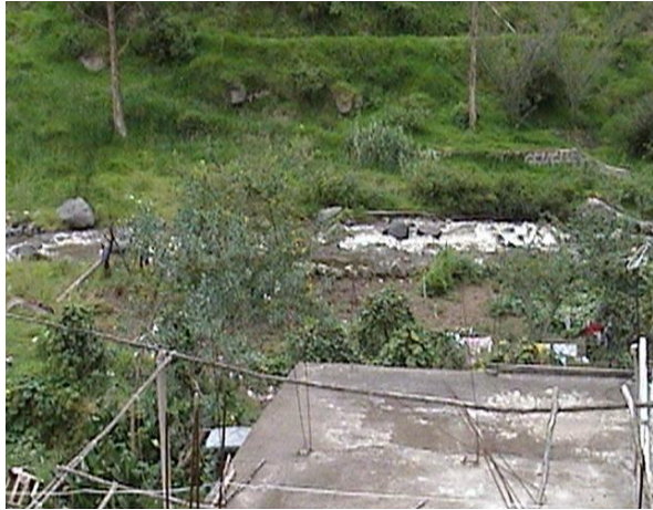
Foto 3: Viviendas ubicadas a pocos metros de la orilla del río, las cuales están expuestas a altos riesgos. (Orillas del río Ambato, 23-02-2012)
