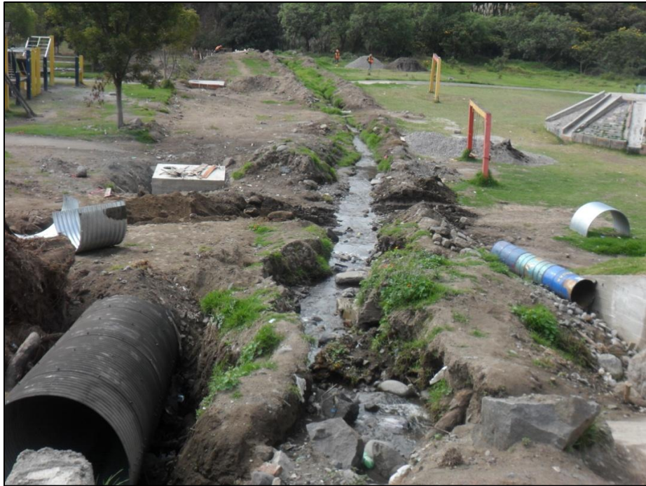
Entubación de la quebrada Jarupana
