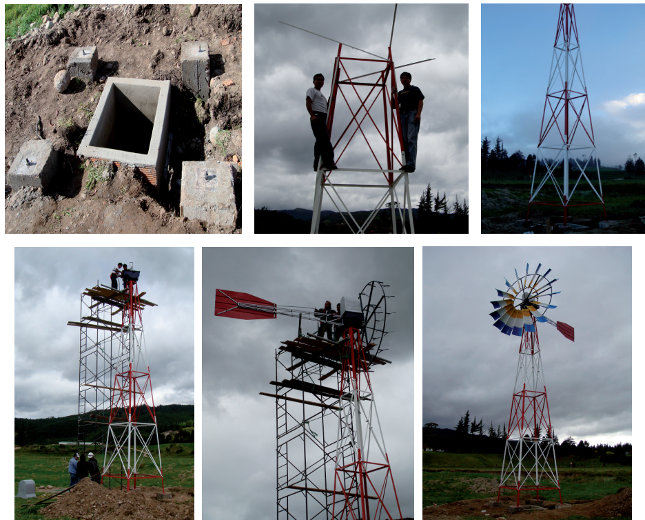
Figura 18. Pasos para la construcción y emplazamiento de la aerobomba en la derivación del Río Irquis
