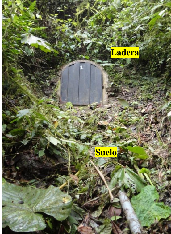
Figura 57. Protección natural en captaciones.
