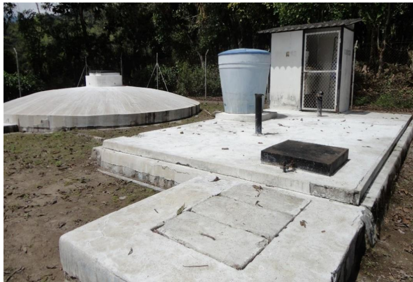
Tanque de distribución rectangular y circular
