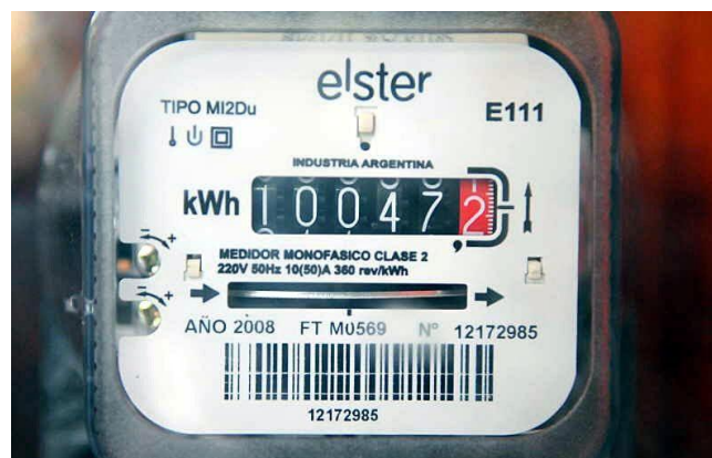
Figura 1.2. Contador de energía electromecánico [6].
