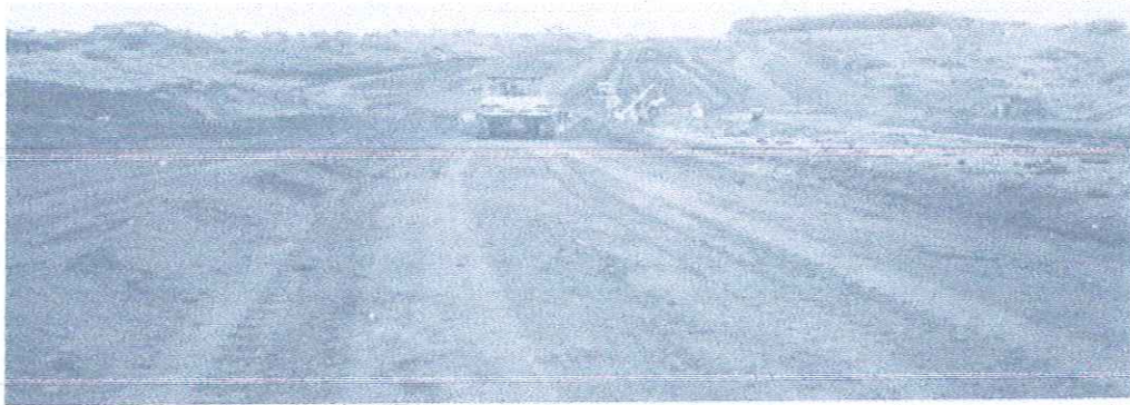
Reparación de la sub-rasante y sub-base de una carretera
