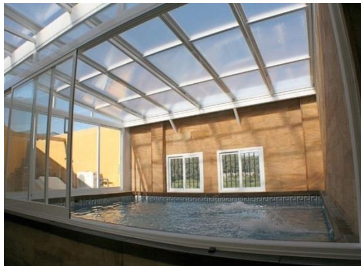
Figura 5. Piscina, con protección a luz solar, rayos UV, ambientes fríos y lluviosos
