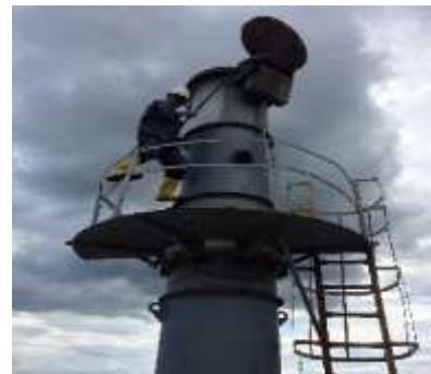
Fotografía N° 12: Chimenea de incinerador
