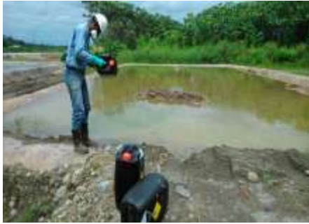
Fotografía N° 13: Tratamiento de agua
