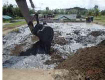
Fotografía N° 14: Aireación mecánica de material contaminado
