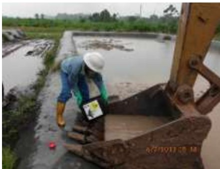
Fotografía N° 15: Incorporación de productos químicos para tratamiento
