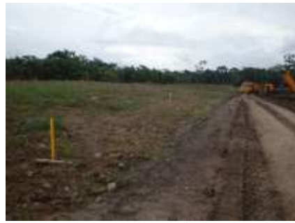
Fotografía N° 8: Vías internas y sitios de operativos de tratamiento
