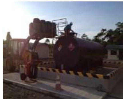
Fotografía N° 16: Abastecimiento de combustible en tanque de almacenamiento
