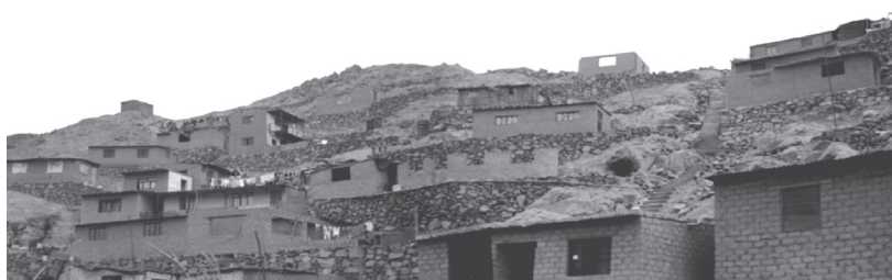
Imagen 20 Casas y miradores en Lima-Casa progresiva en ladera en Lima
