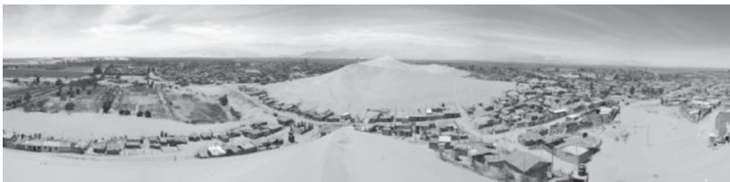
Imagen 19 Adaptación a caminos preexistentes (Ica)
