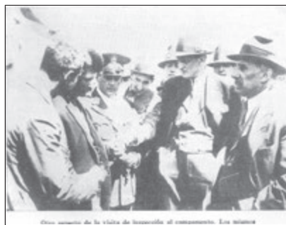
Otros momentos de la visita de inspección al campamento. Los bilanes
