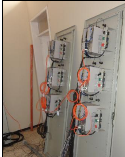
Figura 3.69. Red provisional de fibra óptica. 146
