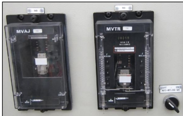
Figura 2.26. Relé de disparo (94) y Renganche (79) – Alimentador primario E- S/E Eugenio Espejo 43
