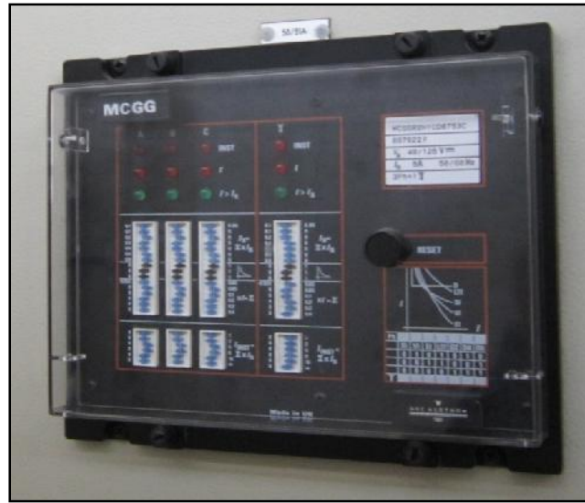
Figura 2.25. Protección 50/51 – Alimentador primario E- S/E Eugenio Espejo 42
