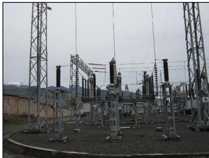
Figura 2.3. Bahía de Línea 138 kV a Selva Alegre – S/E Eugenio Espejo 3
