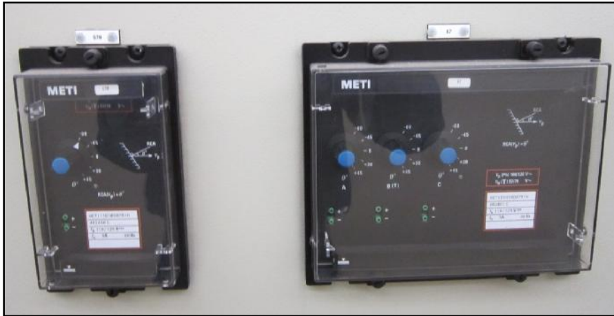
Figura 2.18. Protección 67 – L/T Selva Alegre – 138 kV - S/E Eugenio Espejo 32
