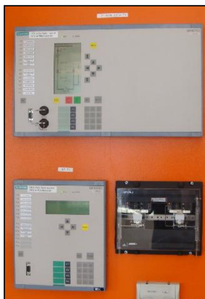
Figura 2.21. Relé Numérico Sobrecorriente y Diferencial de T1 con protocolo de comunicación IEC 103 - S/E Eugenio Espejo 36
