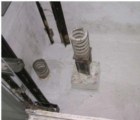
**Figura 1.3** Amortiguadores de muelle con sistema de retención
