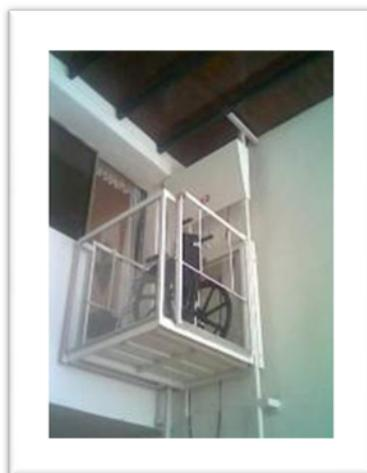
**Figura 2.5** Sistema de elevación con media cabina
