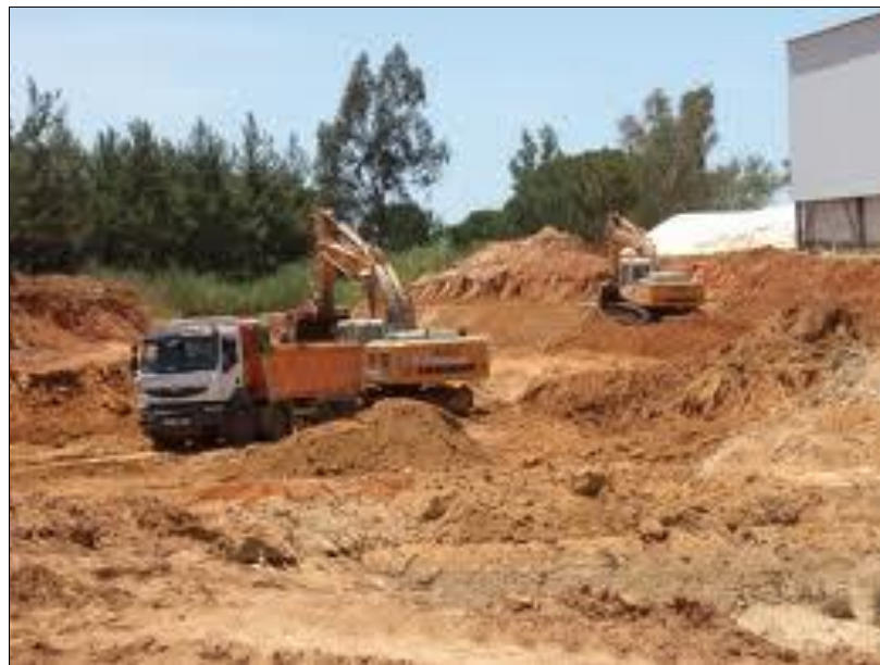
Figura 35. Movimiento de tierras fase de construcción Fuente: Pagina Web Google
