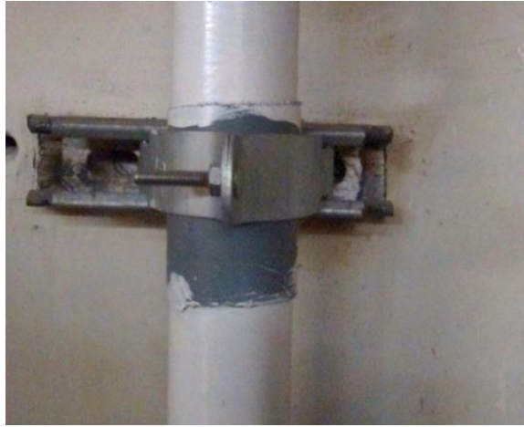
FOTO 03. Anclaje de agarradera con perno de aluminio. 1
