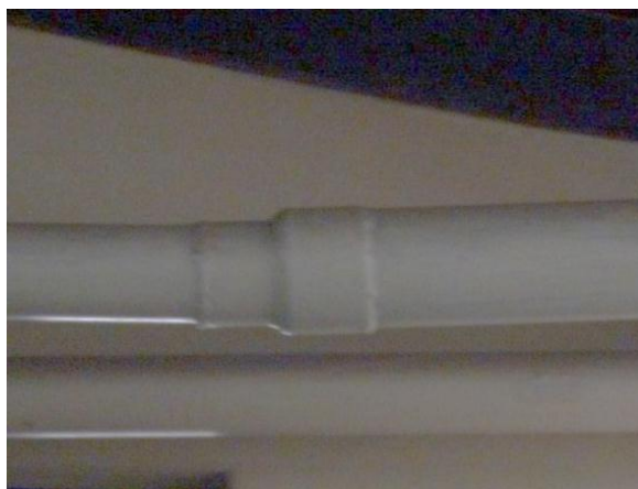
FOTO 05. Aumento de diámetro de tubería de sección sur. 1
