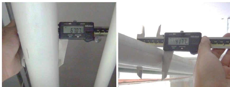
FOTO 06. Reducción de diámetro de tubería de sección sur. 2
