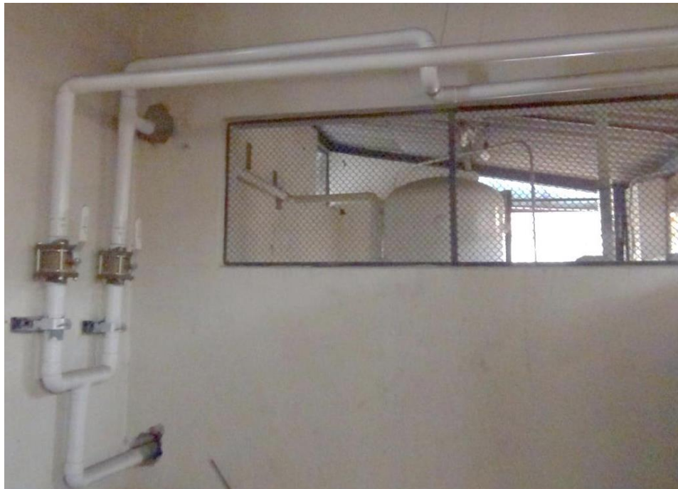
FOTO 04. Bifurcación de línea a sección norte y sur de terapia intensiva. 2
