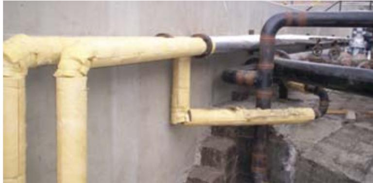
**FIGURA 3.14** Recubrimiento del aislamiento térmico y el foil metálico<sup>159</sup>
