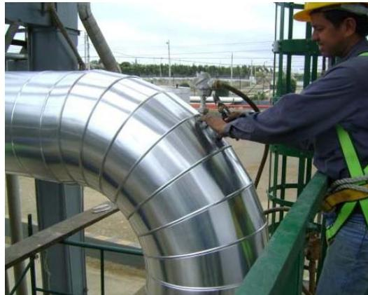
**FIGURA 1.52: Instalación de una tubería para aislar térmicamente el calor**<sup>91</sup>
