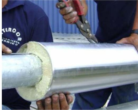
**FIGURA 1.54: Instalación del aislante térmico, recubierto del foil de aluminio.**<sup>93</sup>
