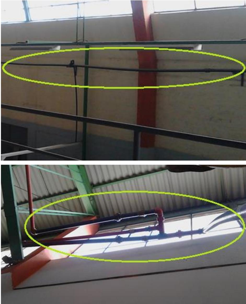
Figura 39. Defectos de la tubería actual
