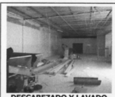
DESCABEZADO Y LAVADO EN CONSTRUCCIÓN
