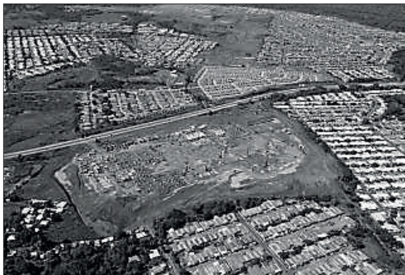
Foto N°2 Panorámica periferia Oeste de Ciudad de Panamá
