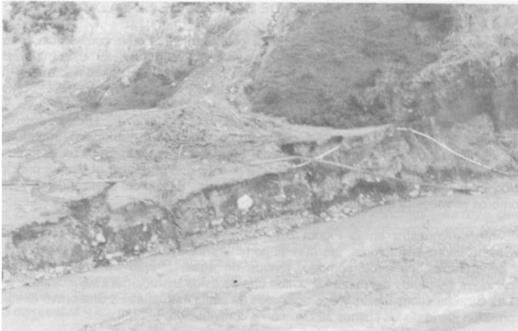
FIGURA 6.8 Tuberías del oleoducto y poliducto (en blanco) trans-ecuatoriano interrumpida por flujos de escombros y erosión profunda a lo largo del Río Coca.
