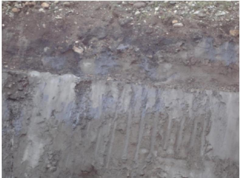
**Fotografía 3.** Manchas de hidrocarburo en suelo pasivo ambiental Estación El Salado N°03
