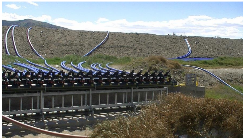
Figura 2.5: Estación de extracción de biogás en el RS del Inga.
