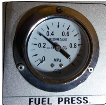
Figura 26. Manómetro de presión de combustible del banco Sonata 2.0. Fuente: Autores
