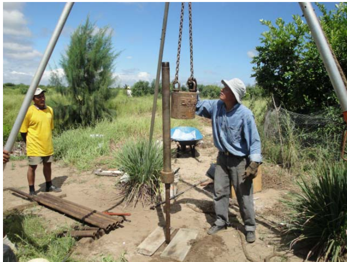
FOTOGRAFÍA 4.2.- Ensayo SPT (P - 1)
