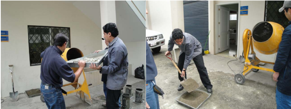
FOTOGRAFÍA 9.13.- Proceso de Mezclado
