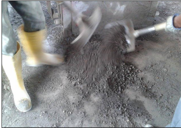
Figura 17. Mezclado del material para la elaboración del bloque.
