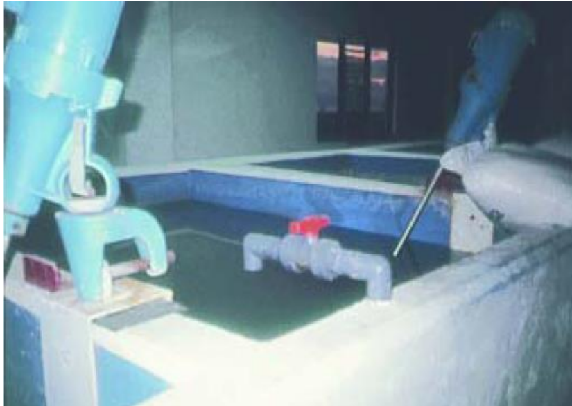
Figura 1-4 Tanque de preparación de la solución
