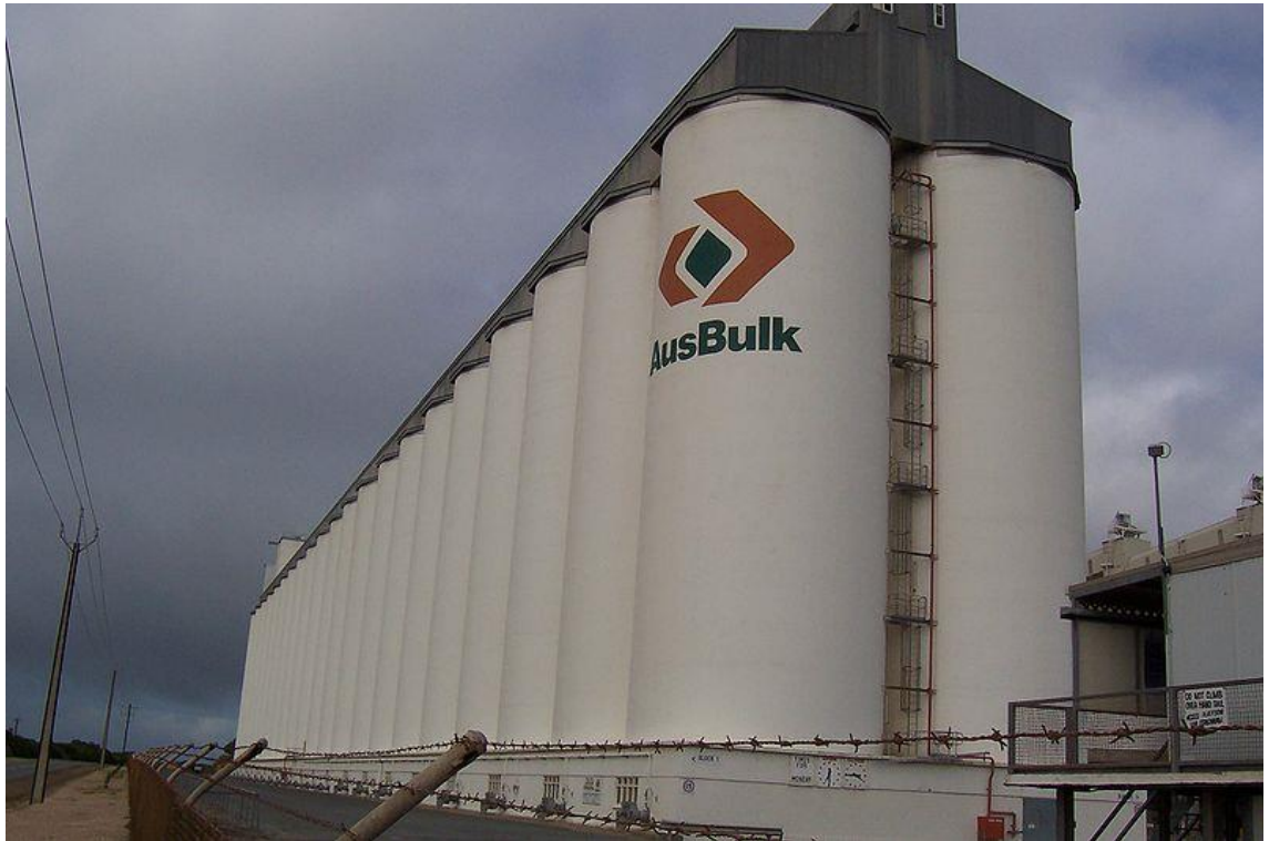
Figura 2-1 Silo de torre
