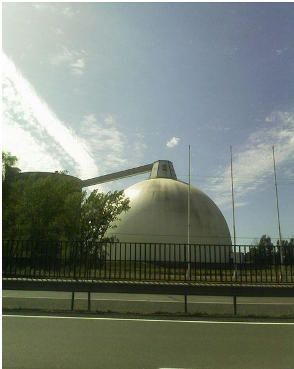
Figura 2-2 Silo tipo búnker
