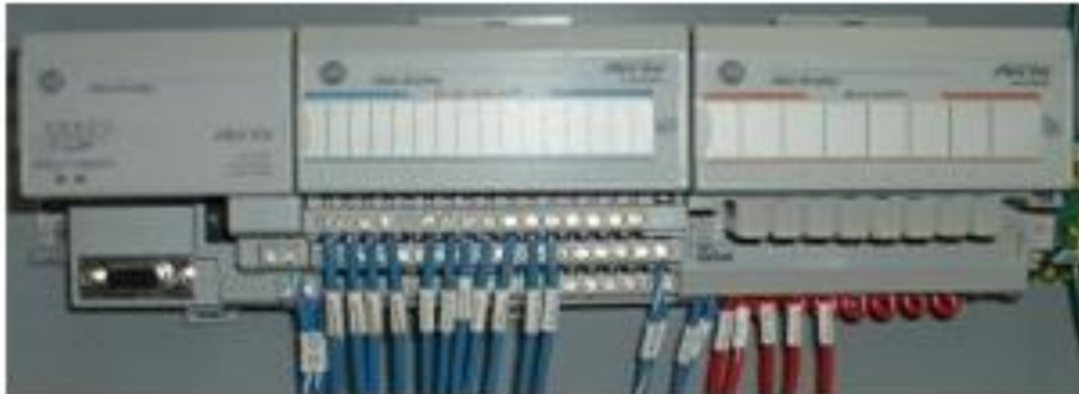
Figura 2-9 Entradas y salidas del PLC
