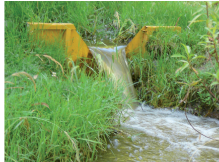
Figura 2. a) (izq.) Vertiente (Yumacay) b) (der.) Vertedero metálico colocado en la vertiente
